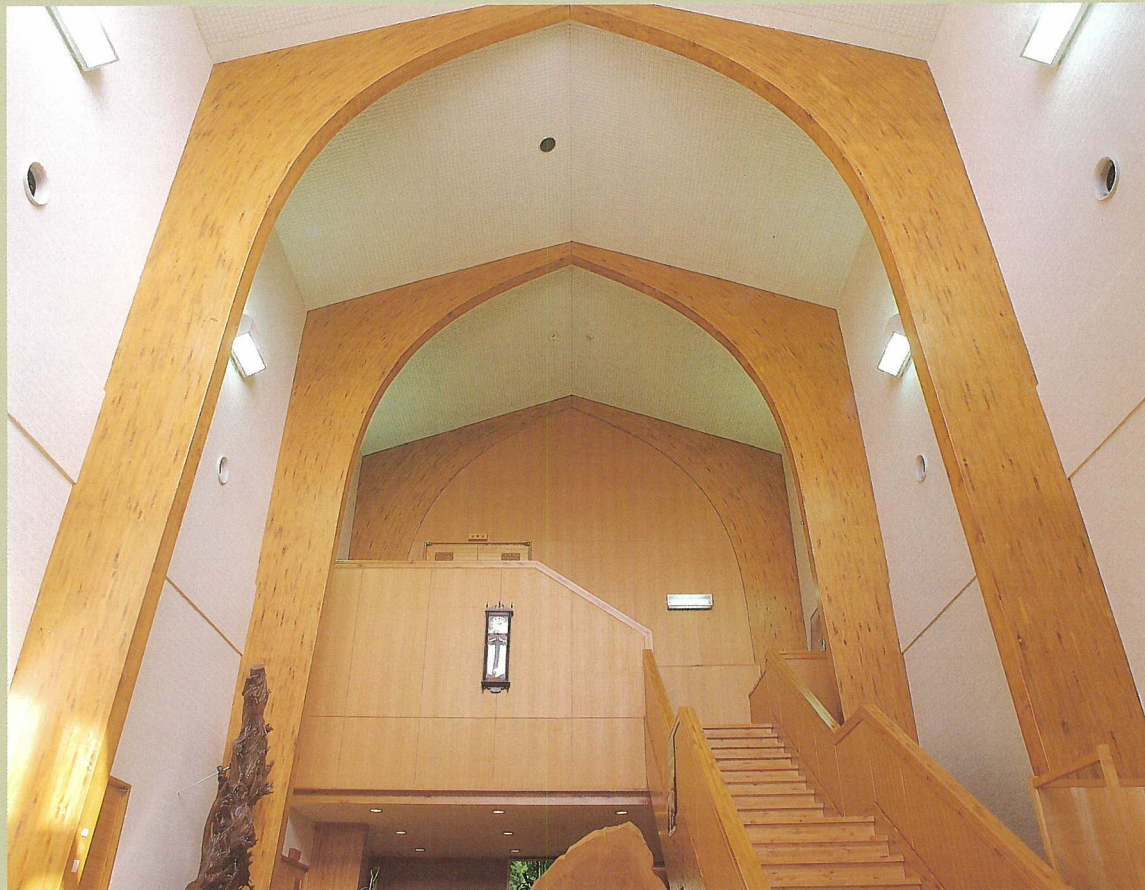
大断面集成材使用のホール
