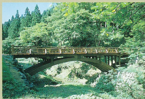
大断面集成材使用の橋
