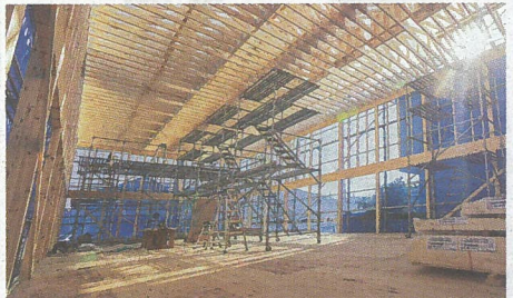
LIDトラスが採用された物件の外観(上)と内部(下)の様子
