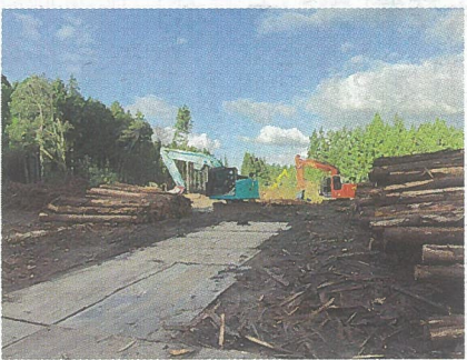
土場での作業の様子
